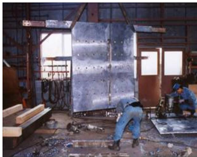
図4. 電極板の修理
