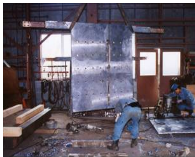
図4. 電極板の修理
