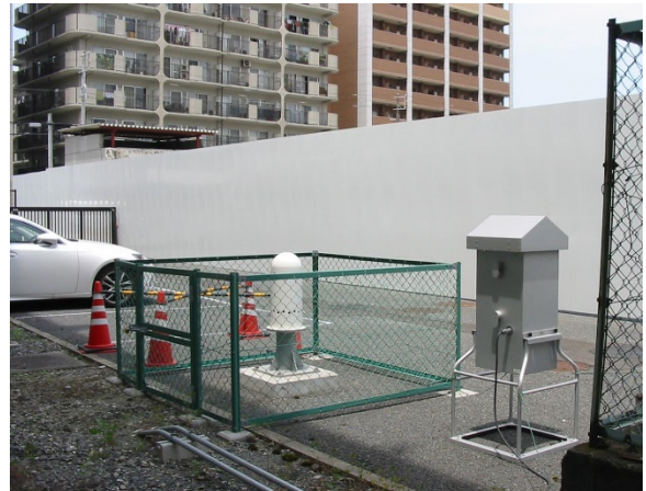
図 5. 大阪市モニタリングポスト横 駐車場解体後
