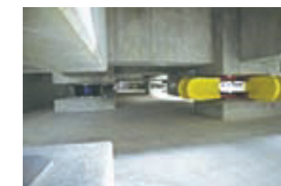
南館免震ビット
